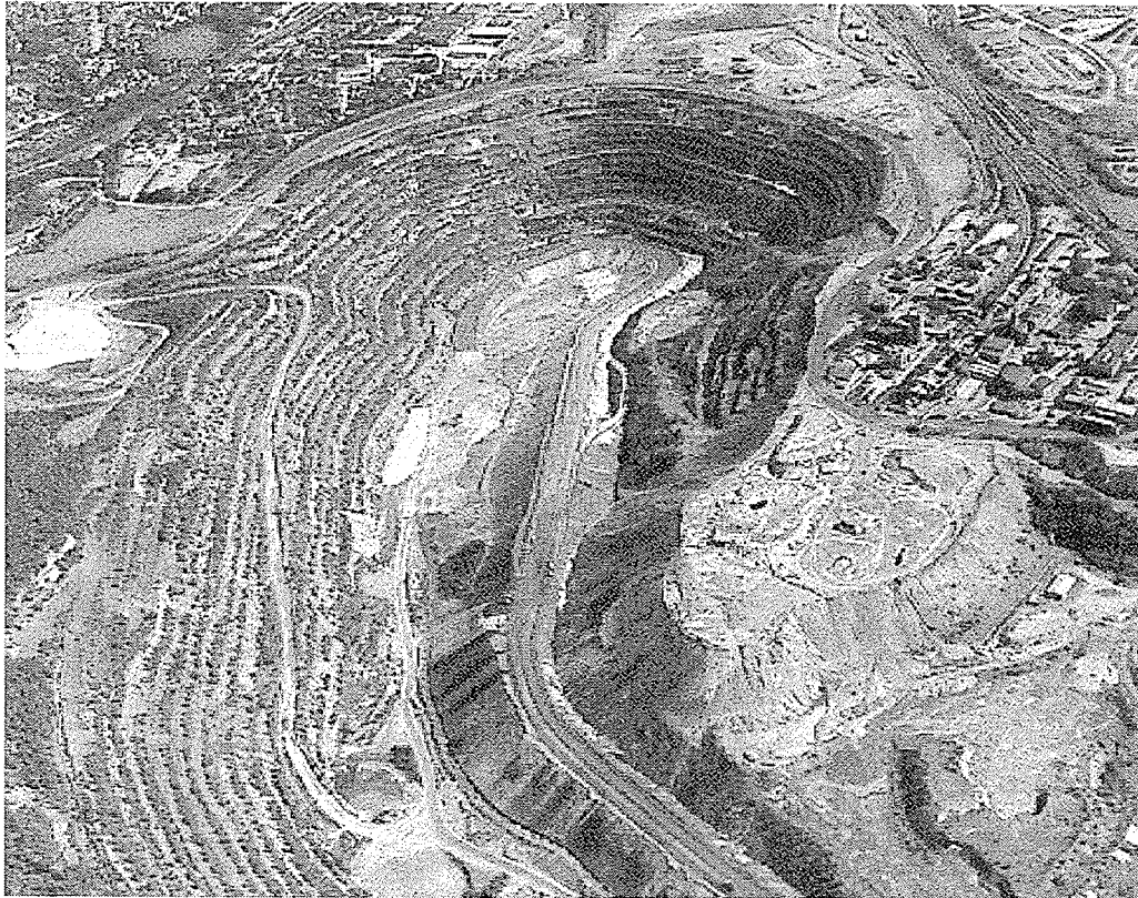
Abbildung 1: Tagebau Lichtenberg bei Ronneburg 1993 (Bild L 278/16, © 1993 Wismut GmbH, Abt. Dokumentation / Überwachung Liegenschaften, Jagdschänkenstr. 29, 09117 Chemnitz)
