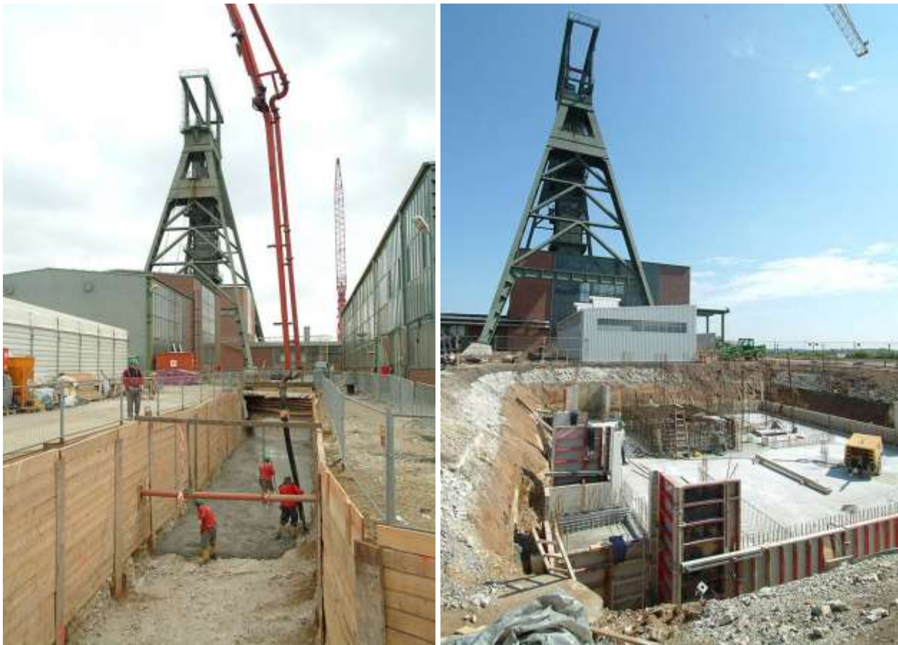
Abbildung D-15: Endlager Konrad in Salzgitter (links: unterirdischer Medienkanal, rechts: Keller des Fördermaschinengebäudes) (Bildrechte: BfS)
