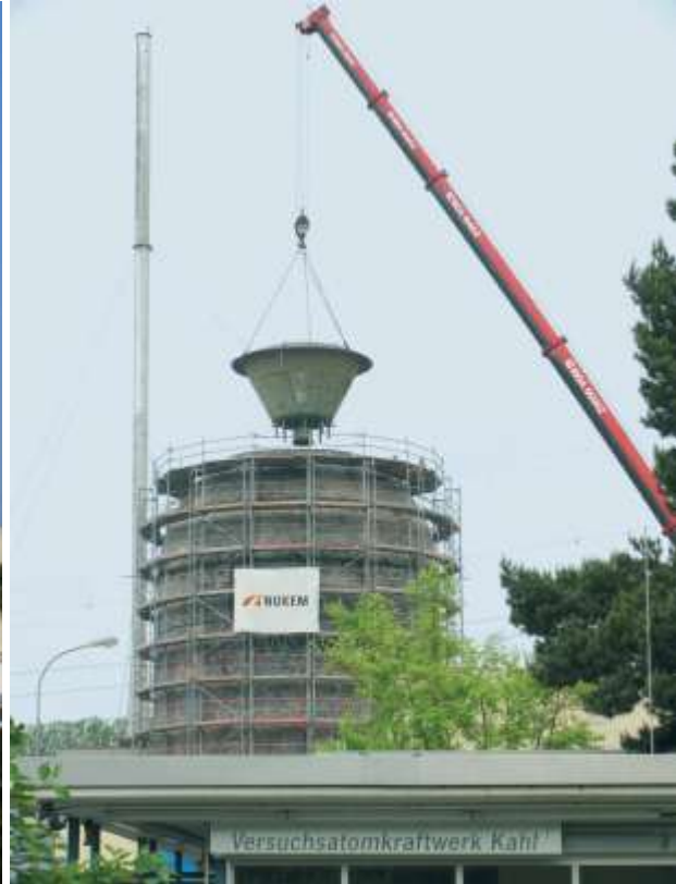
Abbildung D-21: Sukzessiver Abbau des Reaktorgebäudes des Versuchsatomkraftwerk Kahl bis zur „grünen Wiese“ (Bildrechte: NUKEM, BMU, RWE Power)
