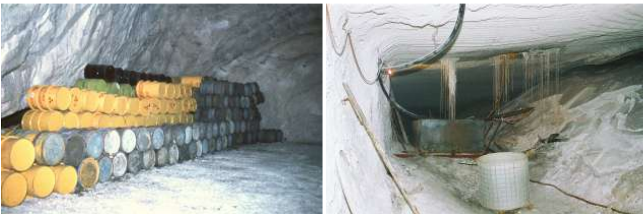
Abbildung D-13: Endlager Schachtanlage Asse II (links: Kammer bei der Einlagerung, rechts: Tropfstelle (vgl. die Ausführungen in H.6.9)) (Bildrechte: BfS)
