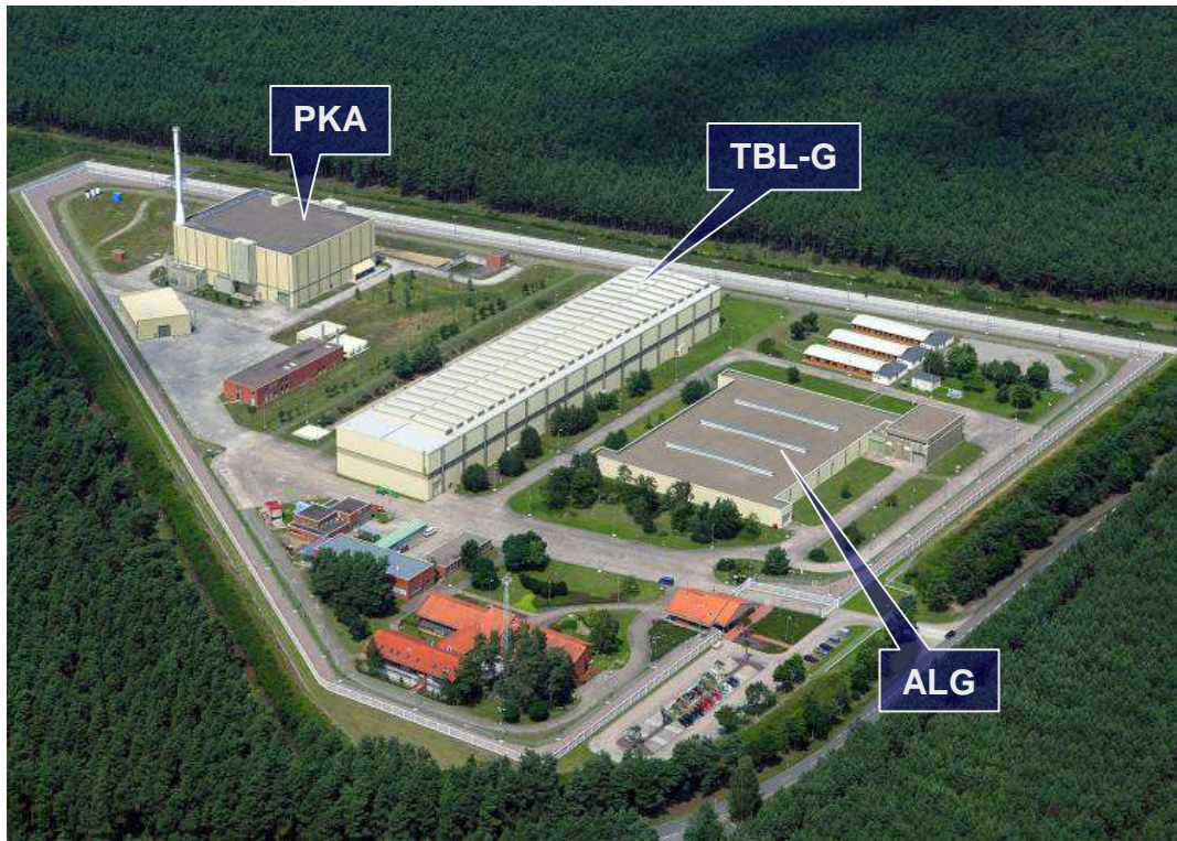
Abbildung D-2: Pilotkonditionierungsanlage (PKA), Transportbehälterlager (TBL-G) und Abfalllager (ALG) der Brennelementelager Gorleben GmbH (Bildrechte: GNS)
