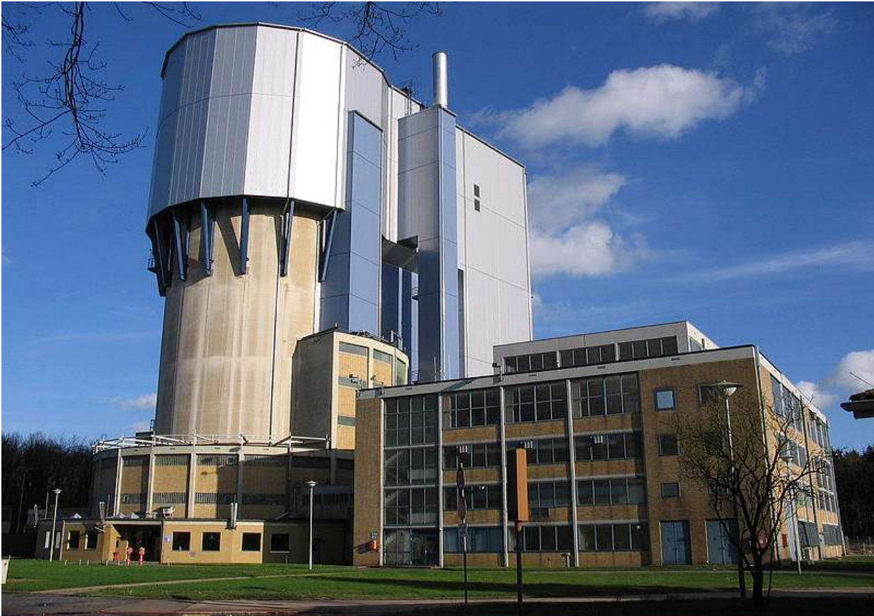
Abbildung D-22: Anbau der Materialschleuse an das Reaktorgebäude des AVR (Bildrechte: EWN)
