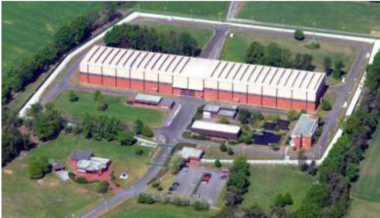
Abbildung G-2: Transportbehälterlager Ahaus (Bildrechte: GNS)
