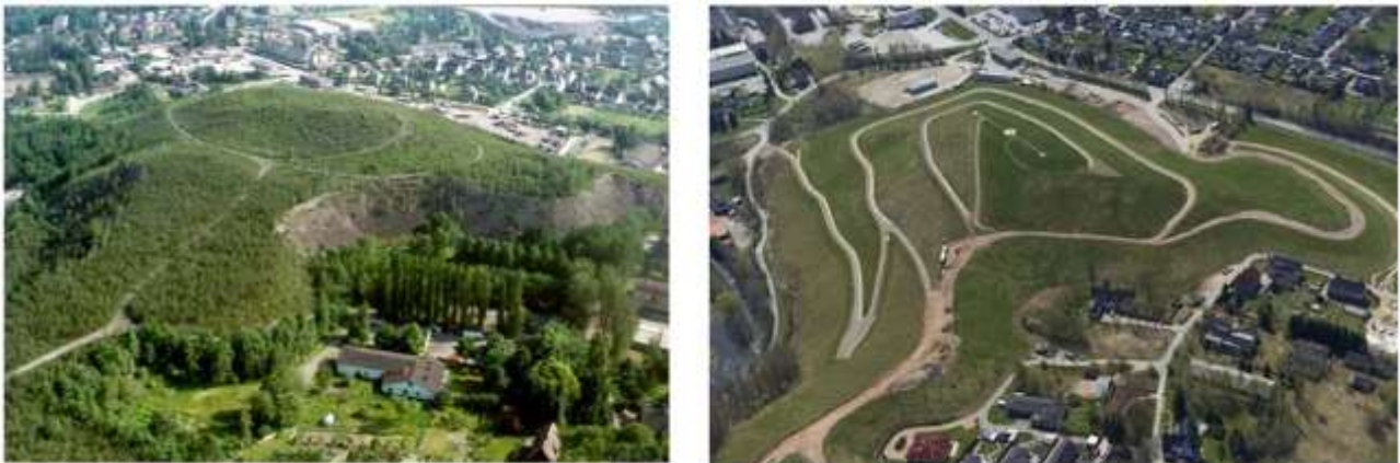
Abb. 1: Sanierung der Halde 66/207 (Standort Schlema, Bereich Edelhofweg) vor und nach der Sanierung
