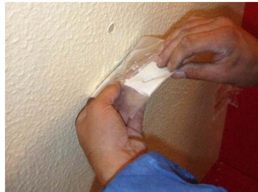
Abb. 10: Folienschleuse auf der Rückseite durch Umklappen des unteren Teiles der Schleuse verschließen
