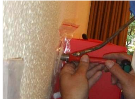
Abb. 8: Restfaserbindemittel durch das offene Henkellocheisen auf die bearbeitete Fläche und auf die ausgestanzte Wandbekleidung sprühen
