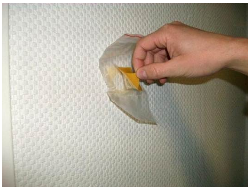
Abb. 5: Schutzfolie des doppelseitigen Klebeband auf der Vorderseite der Schleuse abziehen
