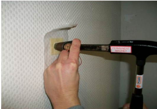
Abb. 7: Wandbekleidung durch die Schleuse ausstanzen
