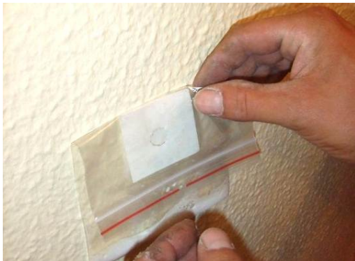
Abb. 9: Öffnung auf der Vorderseite der Schleuse durch Herunterklappen des oberen Teiles der Folienschleuse verschließen
