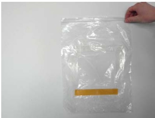
Abb. 3: Schleuse mit dem Verschluss nach oben auf die Wand kleben
