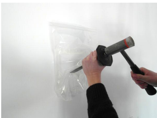
Abb. 5: Flachmeißel auf das doppelseitige Klebband setzen und Wandbekleidung durch die Schleuse ausstemmen
