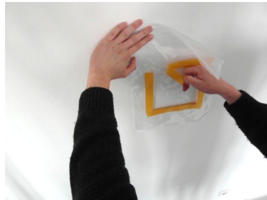
Abb. 2: Schutzfolie des doppelseitigen Klebbandes auf der Rückseite der Schleuse entfernen
