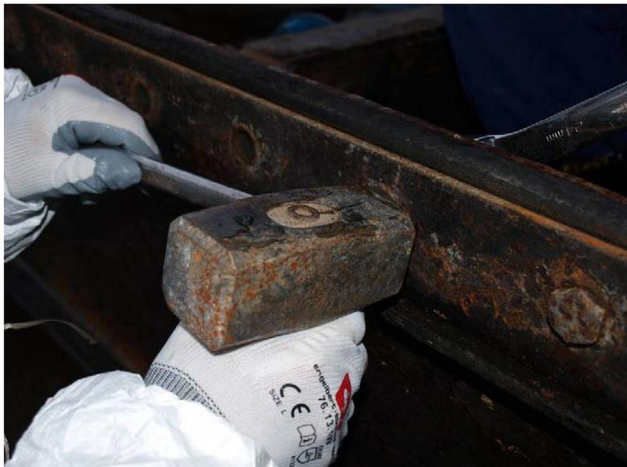
Falls Beschichtung zu dick, im Vorfeld Ringschlüssel mit leichtem Hammerschlag aufsetzen, Rückseite kontern.
