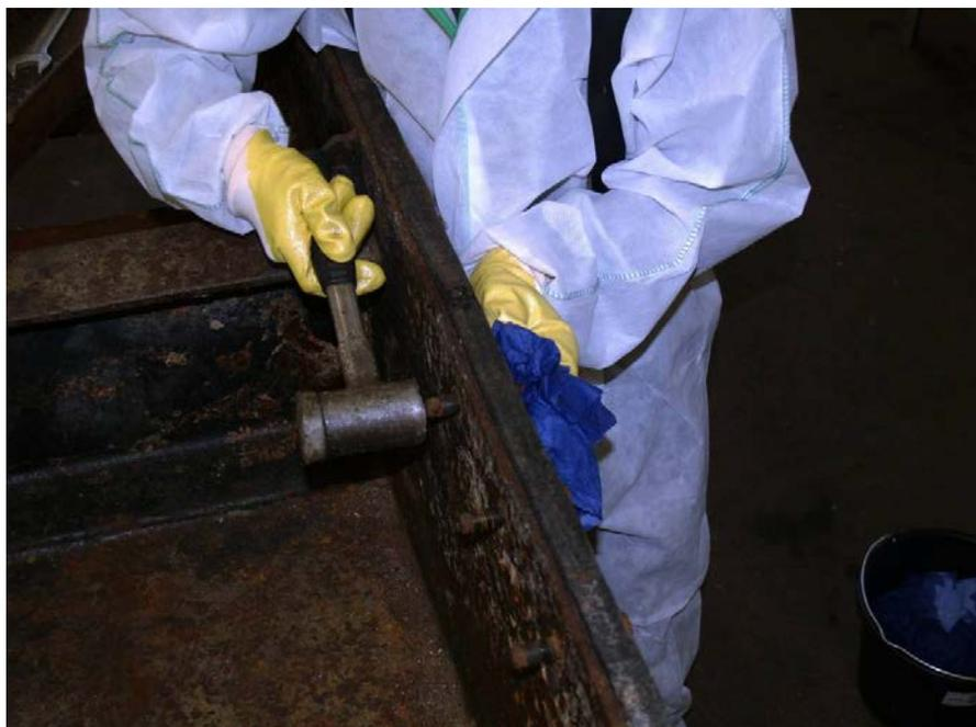
Verbindungsmittel ausschließlich unter Zuhilfenahme eines Hammers mit Kunststoffhammerkopf herausnehmen (sofern sich dieses nicht händisch durchstecken lässt), in mattsfeuchtes Tuch einhüllen und entsorgen.
