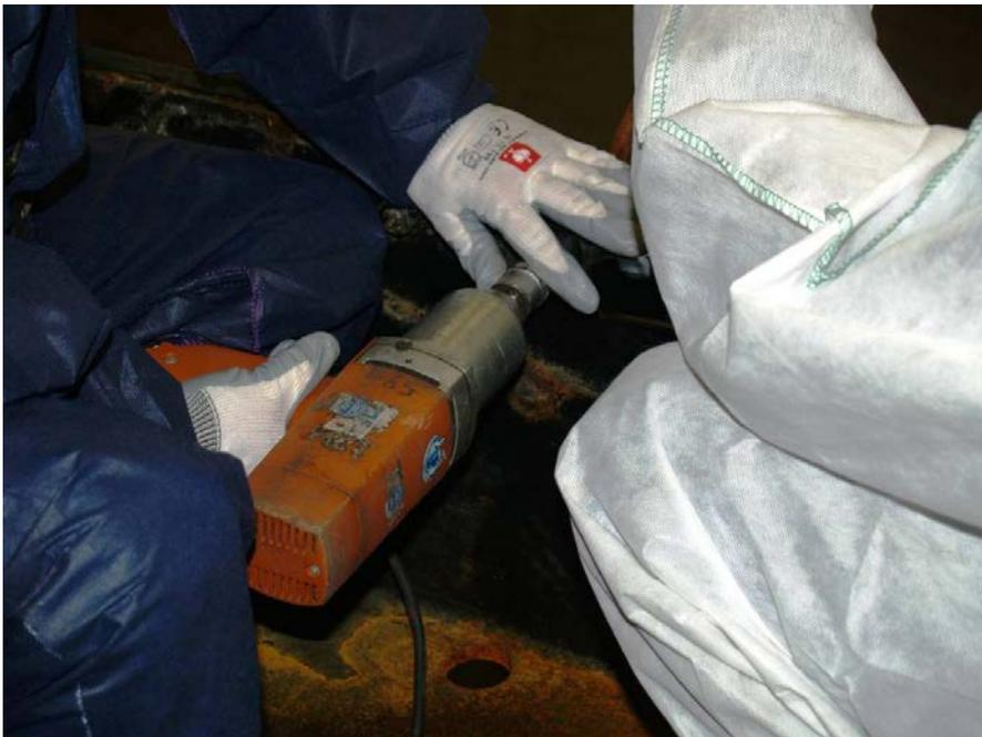
Lösen beschichteter Verbindungsmittel mit Schlagschrauber an einem ehemaligen Bootsschleusentor mit asbesthaltiger Altbeschichtung, fest gebunden (Teerpech-Epoxidharz).
