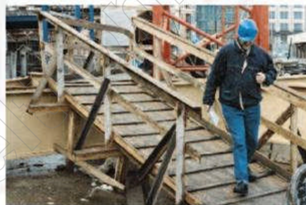
Bild 4-2: Laufsteg mit Trittleisten (wegen Rutschfahr) und Seitenschutz
