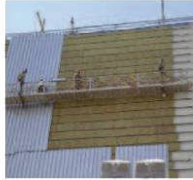
Bild 4-10: Hochziehbares Personenaufnahmemittel am Kran hängend
