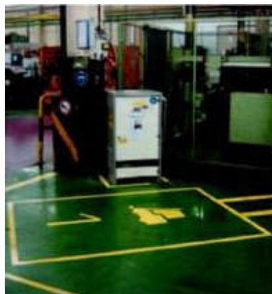
Bild 7-3: Gabelstapler nur an dem dafür vorgesehenen Platz abstellen
