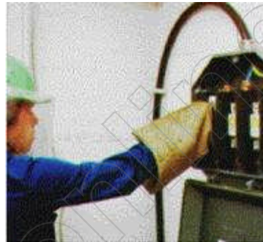
Bild 5-13: NH-Sicherungsaufsteckgriffe mit Stulpe (DIN VDE 0680-4), Industrieschutzhelm nach DIN 4840 mit Gesichtsschutzschirm mit UV-Filterwirkung zum Schutz gegen Störlichtbögen (DIN EN 397)
