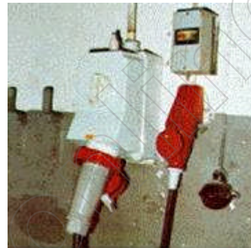
Bild 5-45: Drehstromsteckvorrichtung mit Schalterverriegelung (links)
