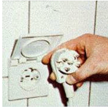
Bild 5-45: Drehstromsteckvorrichtung mit Schalterverriegelung (links)
