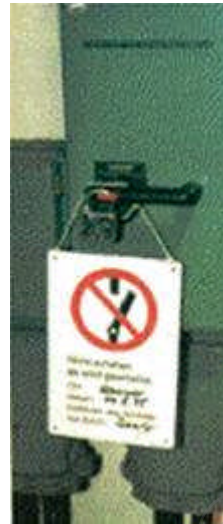
Bild 5-17: Leitungsschutzschalter mit Abschließvorrichtung sichert gegen Wiedereinschalten
