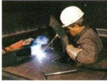
**Bild 4-4: Lichtbogenschweißer unter erhöhter elektrischer Gefährdung zwischen Spanten**
