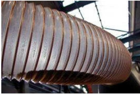
**Bild 37: Anschlussstück zur Vibrationsentkopplung; senkrecht, geerdet**
