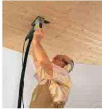
Maschine erst mit dem Sägertisch aufsetzen, dann einschalten. Darauf achten, dass sich das Sägeblatt während des Schneidvorganges unter dem Werkstück frei bewegen kann, z. B. bei Ausschnitten in Decken- oder Wandverkleidungen. Bei mehr als 2stündiger Arbeit mit Handstichsägen oder Handschwingschleifmaschinen täglich sollte wegen der dadurch verursachten Hand-/Armschwingungen der Betriebsarzt informiert werden
