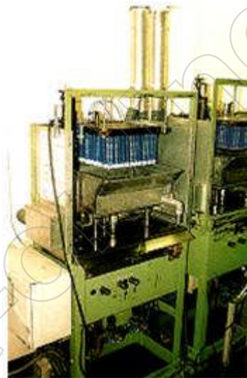
Tauchanlage in der Bleistiftfertigung mit CO 2 -Löschanlage
