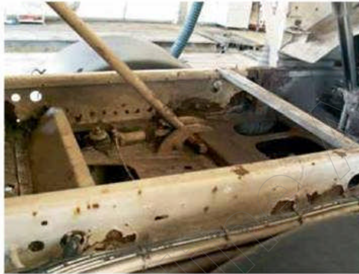
Bild 37: Sicherungsstütze an einem angehobenen Fahrzeugaufbau
