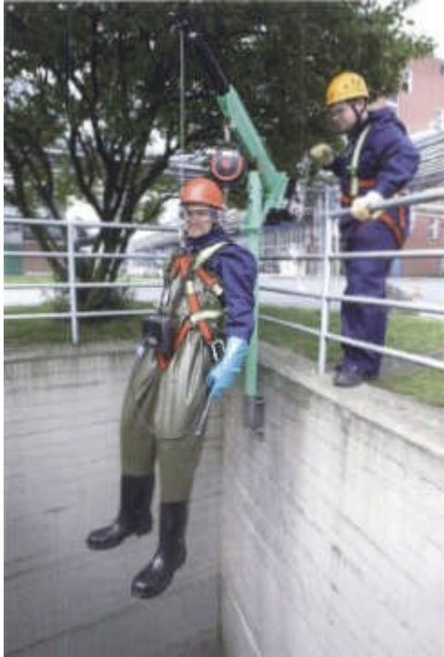
Abbildung 27: Dreibock mit Rettungswinde
