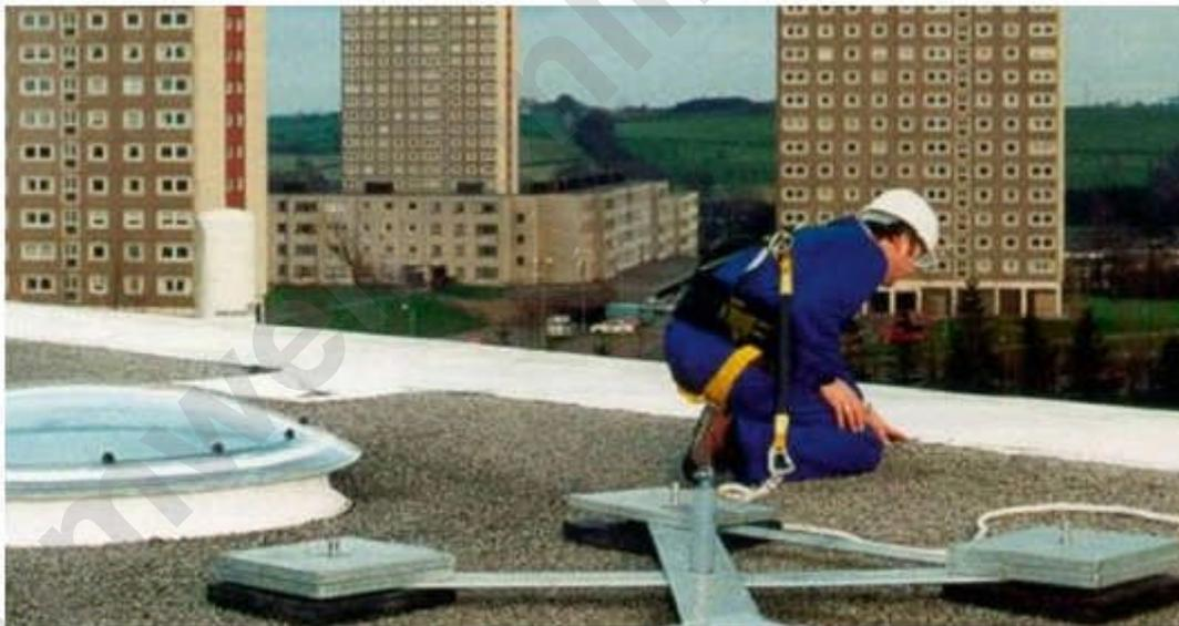
**Bild 24: Beispiele für Anschlageinrichtungen mit horizontalen starren Führungsschienen**
