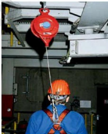
*Der Auffanggurt ist über das ein- und ausziehbare Verbindungsmittel mit dem Höhensicherungsgerät verbunden. Im Absturzfall arretiert eine Bremsvorrichtung im Höhensicherungsgerät das Verbindungsmittel und hält die zu sichernde Person.*
