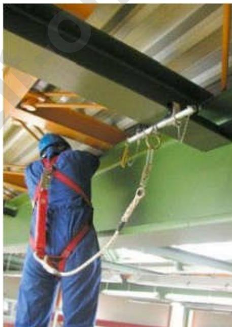
*Der Auffanggurt ist über das Verbindungsmittel mit Falldämpfer am Anschlagpunkt befestigt. Dabei kann der Falldämpfer am Anschlagpunkt/Auffanggurt angeordnet bzw. in dem Verbindungsmittel integriert sein.*
