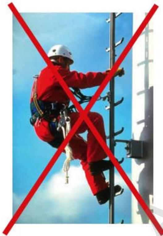
**Bild 27: Falsches Anschlagen eines Seiles mit Falldämpfer**
