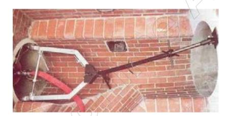
7.3.4 Beim Aufbringen und Ablassen des Prüfdruckes sowie während der Druckprüfung dürfen sich keine Personen vor dem Absperrgerät oder in den anschließenden Haltungen und Schächten aufhalten.
