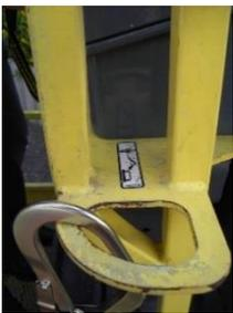
Abbildung 2: Anschlagpunkte für PSAgA
