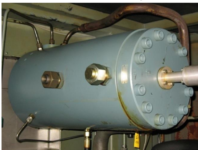
Bild 1: Hydraulischer Druckübersetzer
