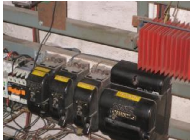
Abbildung 12 – Asbesthaltige Leichtbauplatte (heller Hintergrund) bzw. asbesthaltige Pappe hinter Schaltelementen
