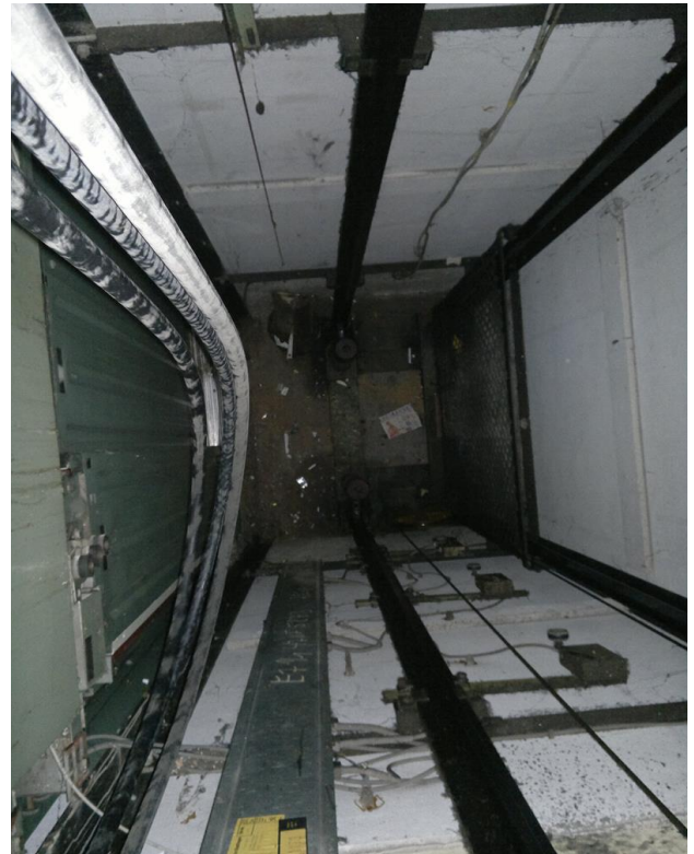
Abbildung 8 – Mit Asbestplatten verkleideter Aufzugsschacht
