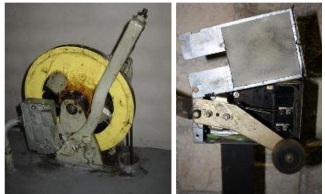
Abbildung 12 – Asbesthaltige Leichtbauplatte (heller Hintergrund) bzw. asbesthaltige Pappe hinter Schaltelementen
