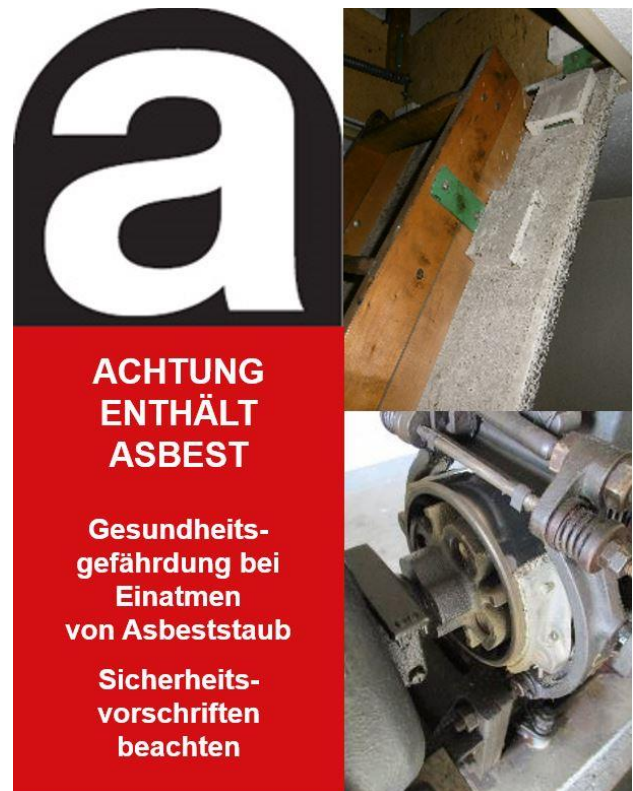
Abbildung 1 – Asbestwarnung, Lukendeckel mit beplankter asbesthaltiger Leichtbauplatte, asbesthaltiger Bremsbelag
