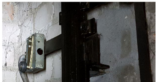
Abbildung 13 – Schalter eingesetzt als Geschwindigkeitsbegrenzer, Fangkontakte und Schachtschalter (Schalterserie 6098)
