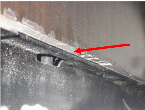
Abbildung 20 – Asbestzementplatten hinter der Kabinenverkleidung
