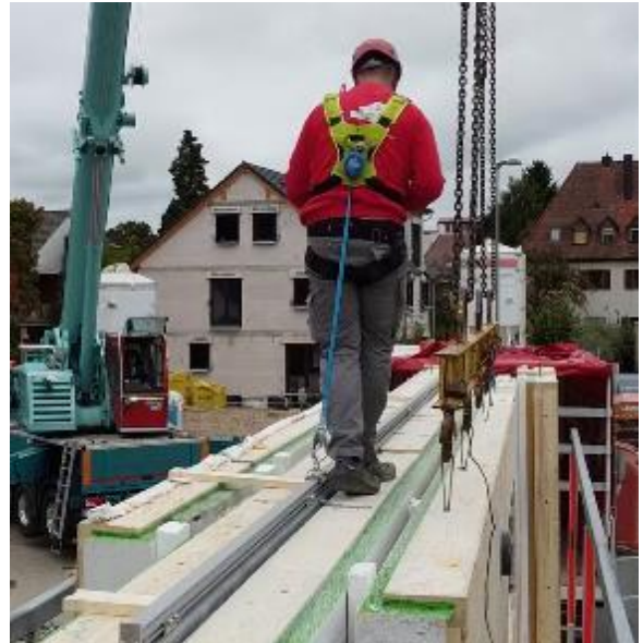
Abbildung 39 – Am Fahrzeugaufbau befestigte Anschlagvorrichtung Höhensicherungsgerät wird an einer Anschlagvorrichtung (Schienensystem) befestigt.
