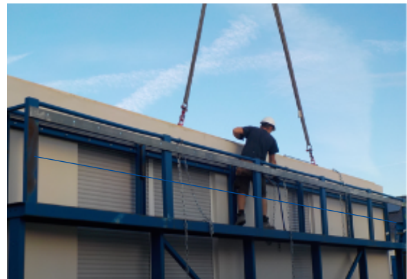
Abbildung 12 – Ladegestell mit klappbarem Mittellaufsteg (z. B. H-Bock) Mittelgang ermöglicht einen sicheren Standplatz, Aufstiegsleitern am Gestell
