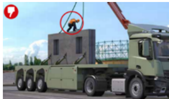
Abbildung 1 – Unzulässiger Aufenthalt auf Ladung ohne Sicherungsmaßnahmen
