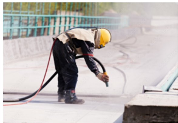
Abbildung 1 – Manuelle Freistrahlarbeiten – Wenn bei den Arbeiten mit Gefahrstoffen zu rechnen ist, sollte vorzugsweise ein glatter einteiliger Schutzanzug getragen werden, um Verschleppungen zu vermeiden.
