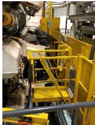
Abbildung 40 – Hubarbeitsbühne mit ausgefahrener Walzenwechselbühne
