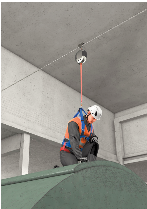
Abbildung 6 – Beispiel für eine dauerhaft befestigte Anschlagseinrichtung mit horizontalem Seilsystem und einem daran angeschlagenen Höhensicherungsgerät
