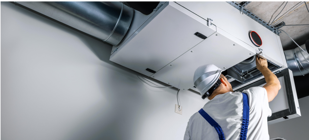
Abbildung 4 – Wartung einer RLT-Anlage
