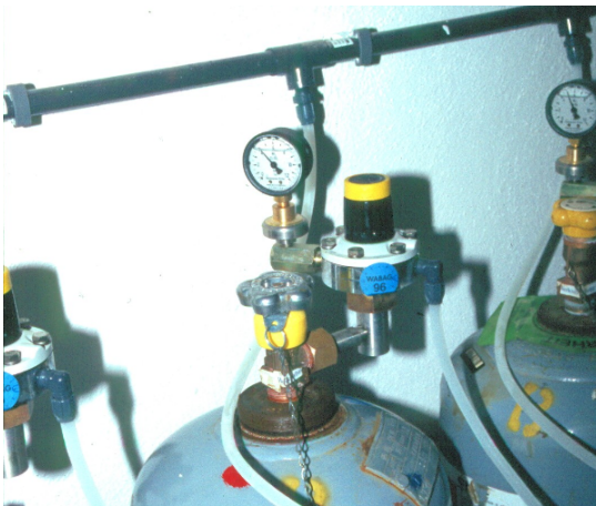
Abbildung 2: Flaschenventil und Vakuumregelventil
