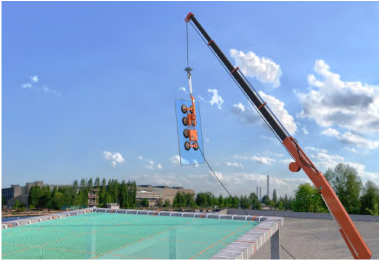
Abb. 8 Max. 3,0 m über der Arbeitsplattformfläche (Versuchsaufbau, Konstruktionshöhe unter 2 m)
