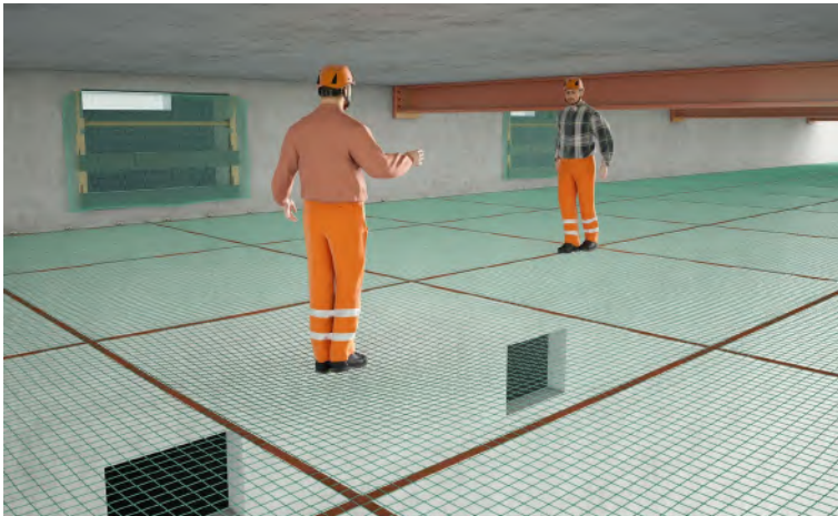
Abb. 1 Montiertes Arbeitsplattformnetz in einer Stahl-/Betonkonstruktion
