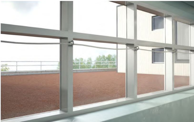
Abb. 13 Montage mit Hohlwandanker und Ringschraube mit Stahlseil an Stahlrohrpfosten und Massivstahlstützen
