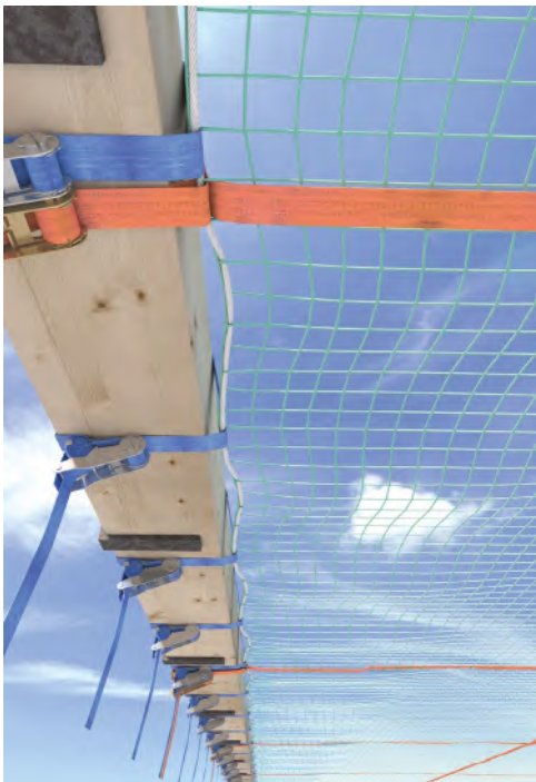
Abb. 5 Randbefestigung mit Anschlaggurten (Quelle: Baustein B 105)
