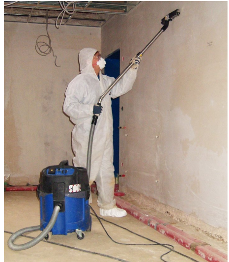
Abb. 7 Feinreinigung des Sanierungsbereiches
