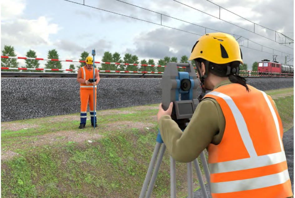
Abb. 28 Vermessungsarbeiten im Bereich von Gleisen
