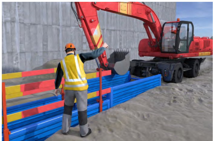
Abb. 25 Grabenverbaugeräte und Absturzsicherung
