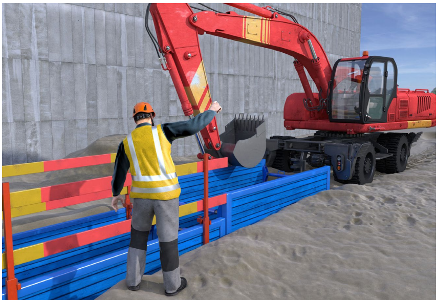
Abb. 21 Grabenverbaugeräte und Absturzsicherung
