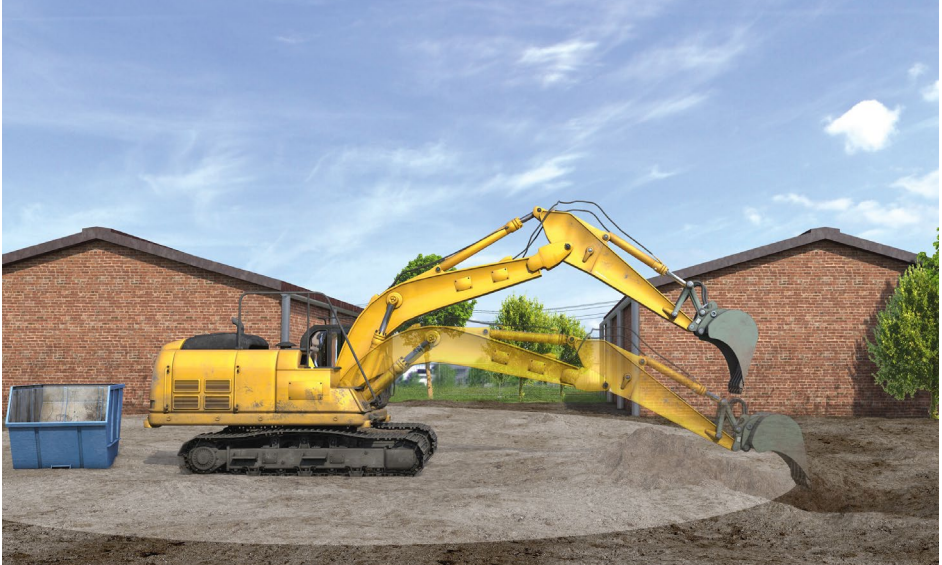
Abb. 18 Gefahrbereich beim Betrieb eines Baggers
