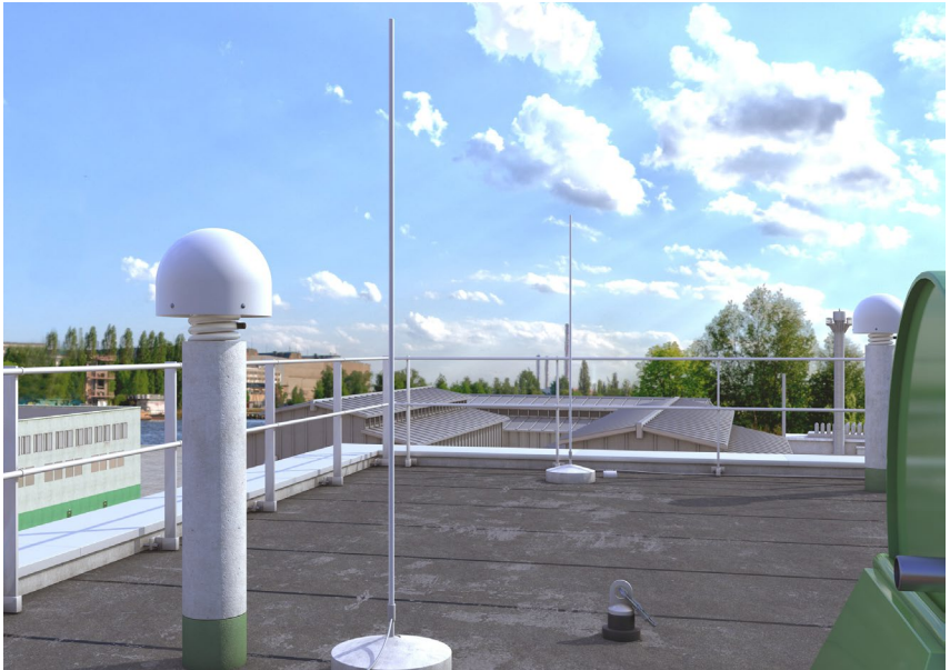
Abb. 9 Referenzstation auf einem Flachdach
