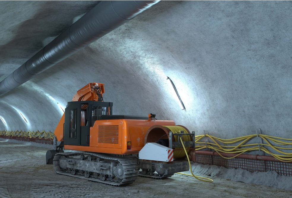
Abb. 11 Bagger mit Elektroantrieb
