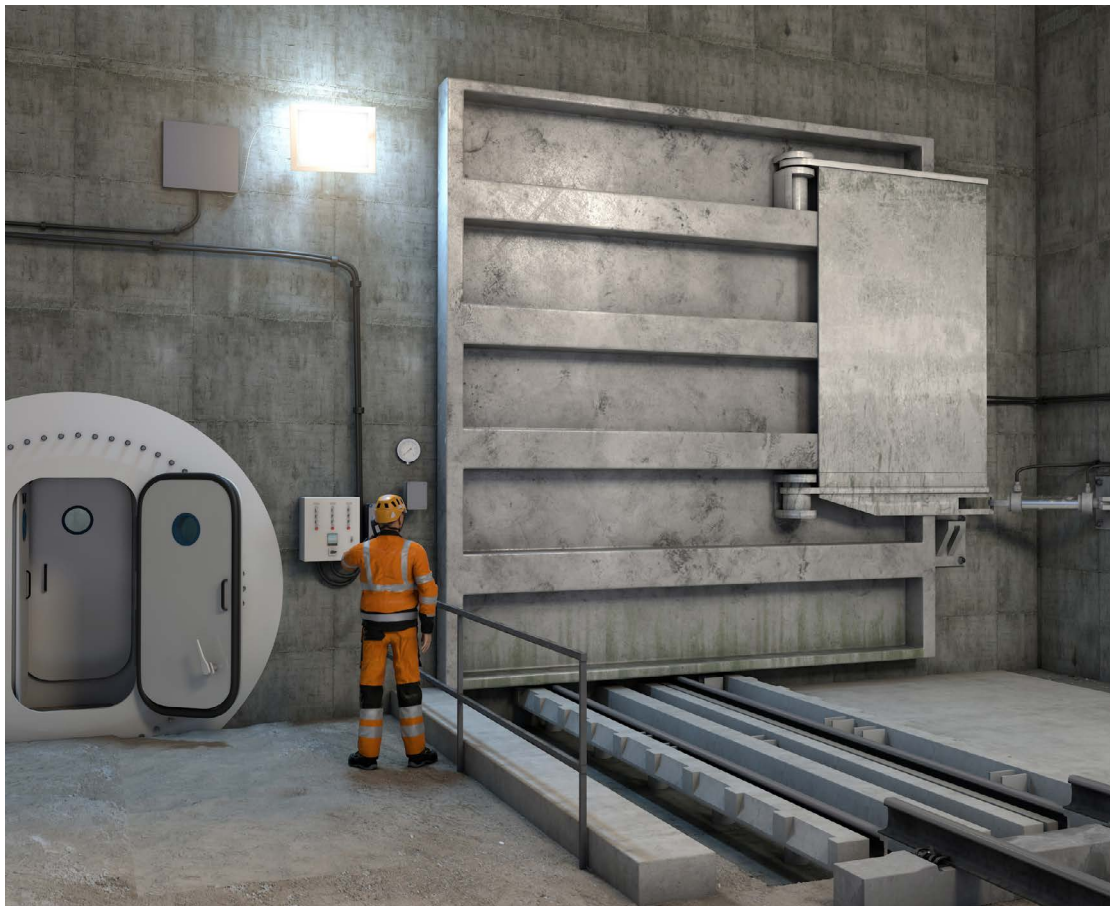
Abb. 10 Schleusentor einer Großschleuse zur Materialförderung mit Gleisbetrieb
