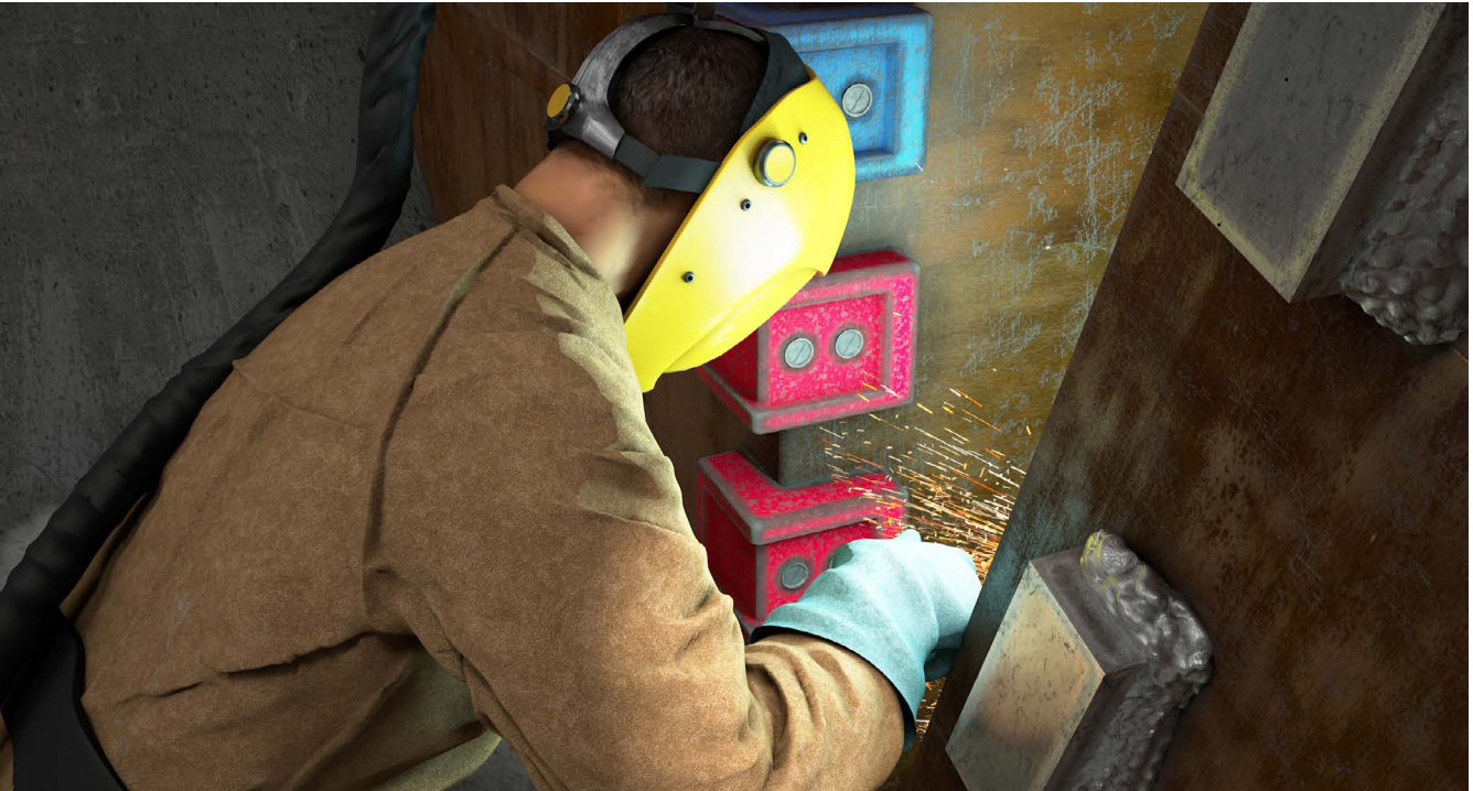
Abb. 3 Schweißarbeiten in Druckluft mit umgebungsluftunabhängiger Atemluftversorgung
