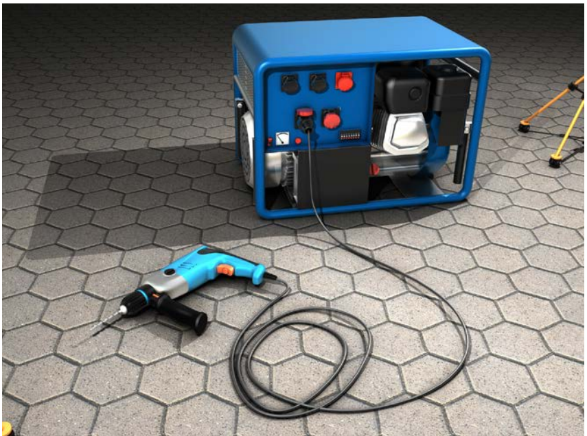
Abb. 4 Ein einzelne Betriebsmittel direkt am Stromerzeuger angeschlossen
