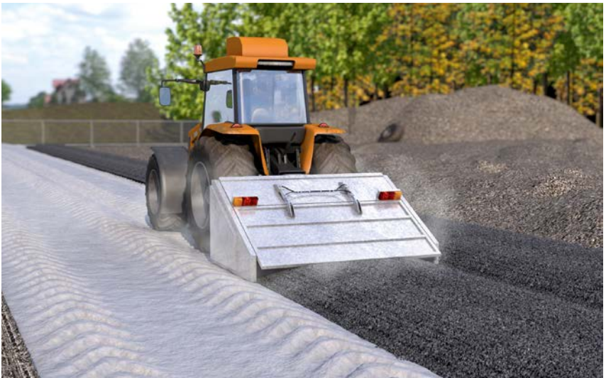
Abb. 14 Bodenstabilisierung
