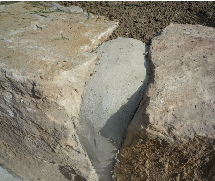
Abb. 12 Zwischenräume bei Steineinfassungen dürfen keine Fangstellen aufweisen
