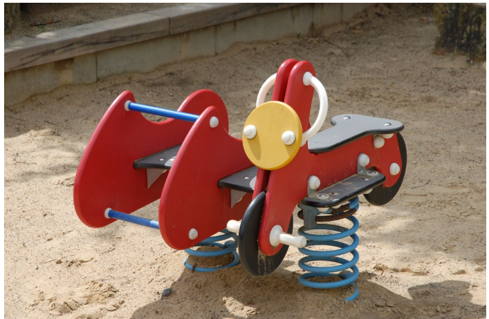
Abb. 6 Beispiel eines Wipptieres mit geeignetem Fallschutz
