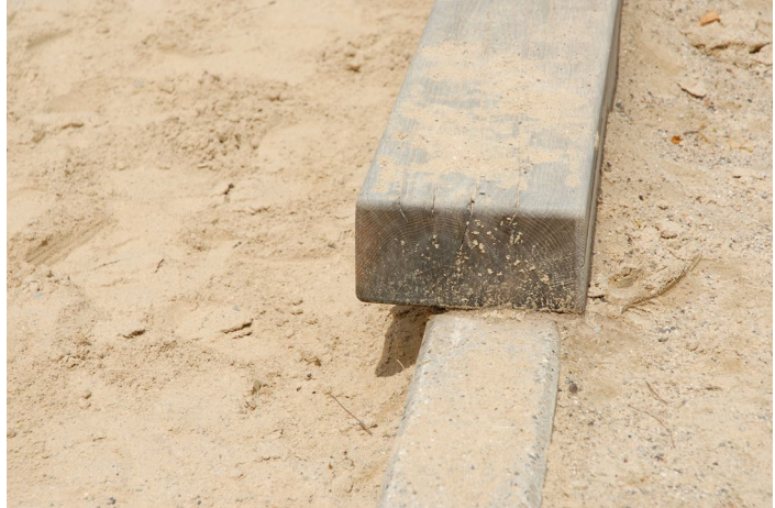
Abb. 10 Einfassung für Sandkästen aus Holzbalken mit ge- rundeten/gefasten Kanten (Beispiele)
