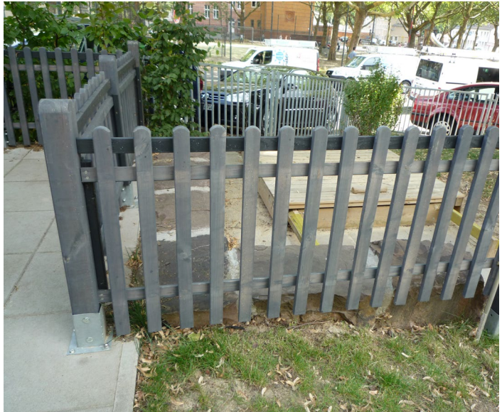
Abb. 16 Zäune dürfen keine Spitzen und keine Fangstellen besitzen
