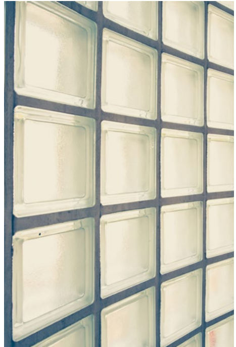
Abb. 9 Wände aus Glassteinen können ausreichend verkehrs- und ballwurfsicher sein
