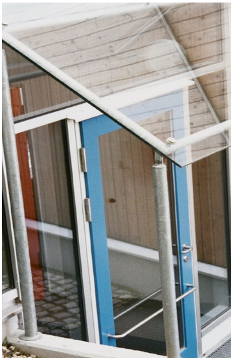
Abb. 5 Überkopfverglasung aus VSG
