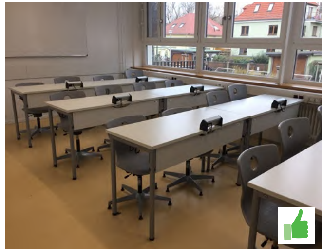
Positives Beispiel: In Schultische integrierte Steckdosen schützen die Verkabelung und tragen zur Vermeidung von Stolperstellen bei. Hilfreich ist auch die Ergänzung einer USB-Ladeleiste oder eines LAN-Anschlusses.
