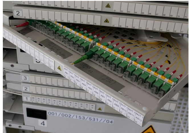
Abb. 11 Beispiel einer konstruktiven Schutzmaßnahme bei einer LWLKS-Steckverbindung in einem Patchfeld. Die Frontblende schützt u. a. gegen Strahlaustritt bei nicht belegten Ports.
