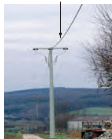
20 kV-Freileitung – isoliert
