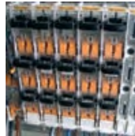
Lasttrennschalter mit NH-Sicherungen
