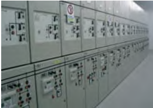
20 kV-SF 6 -Schaltanlage
