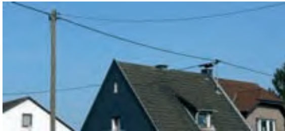
20 kV-Freileitung – isoliert
