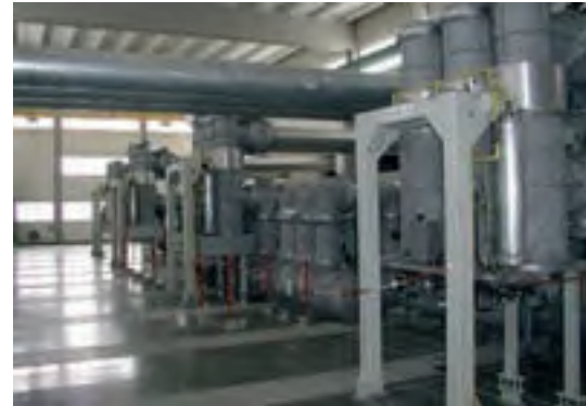
110 kV-SF 6 -Schaltanlage
