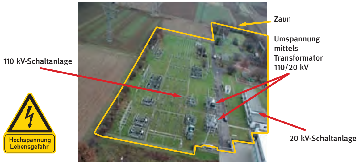
Luftbild einer Umspannanlage 110/20 kV
