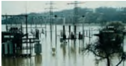
Überflutete Freiluftschaltanlage
