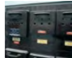
Lasttrennschalter mit NH-Sicherungen
