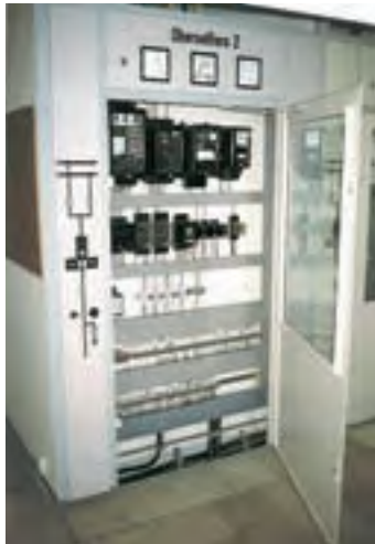
Netzschutz elektromechanische Ausführung
