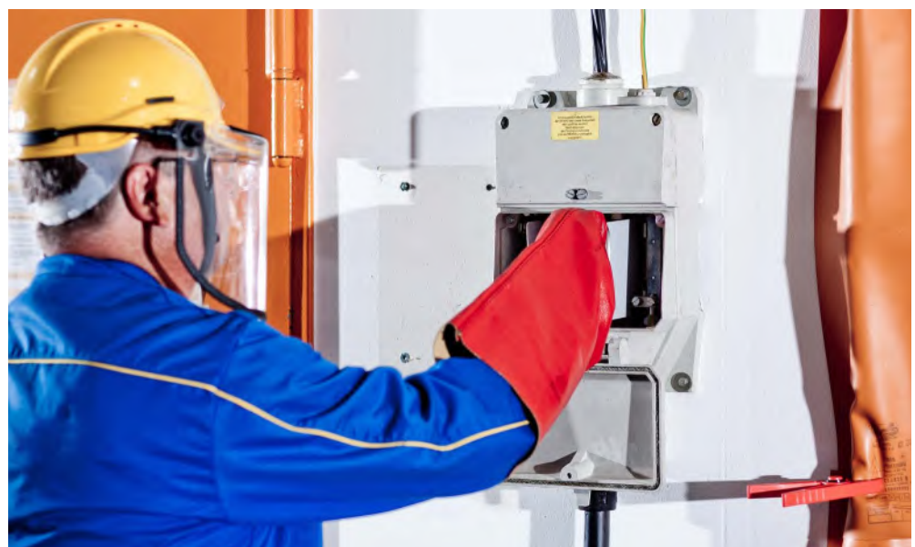
Abb. A 5-11 Entfernen und Einsetzen von NH-Sicherungen am Hausanschlusskasten
