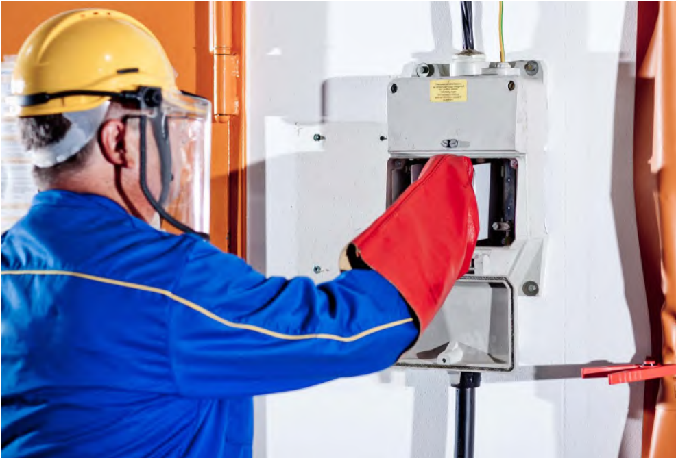
Abb. A 6-1 Arbeiten am Hausanschlusskasten: k_T = 1,0
