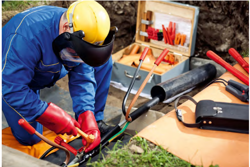
Abb. A 5-6 Arbeiten an einer Kabelmuffe
