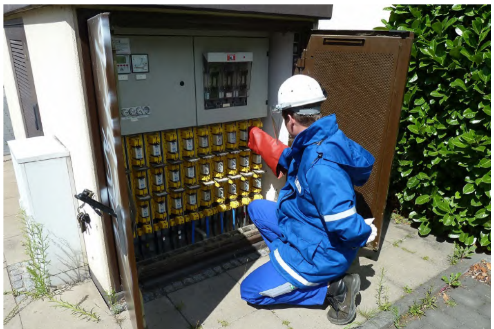
Abb. A 6-4 Arbeiten an einer Kompaktstation: k_T = 1,7
