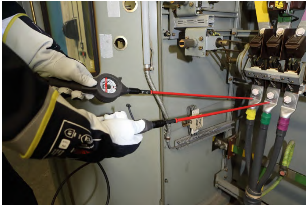
Abb. A 5-22 Feststellen der Spannungsfreiheit
