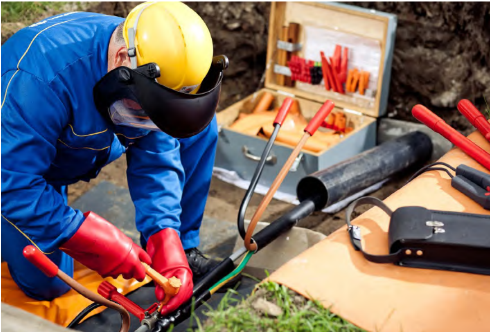
Abb. A 6-5 Muffenmontage: k_T = 1,9
