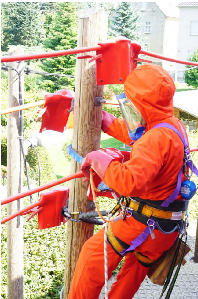
Abb. A 6-6 Arbeiten auf dem Mast: k_T = 2,4
