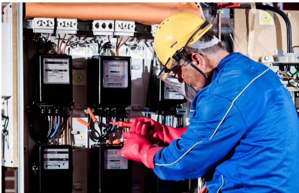
Abb. A 5-10 Arbeiten hinter der Hauseinspeisung
