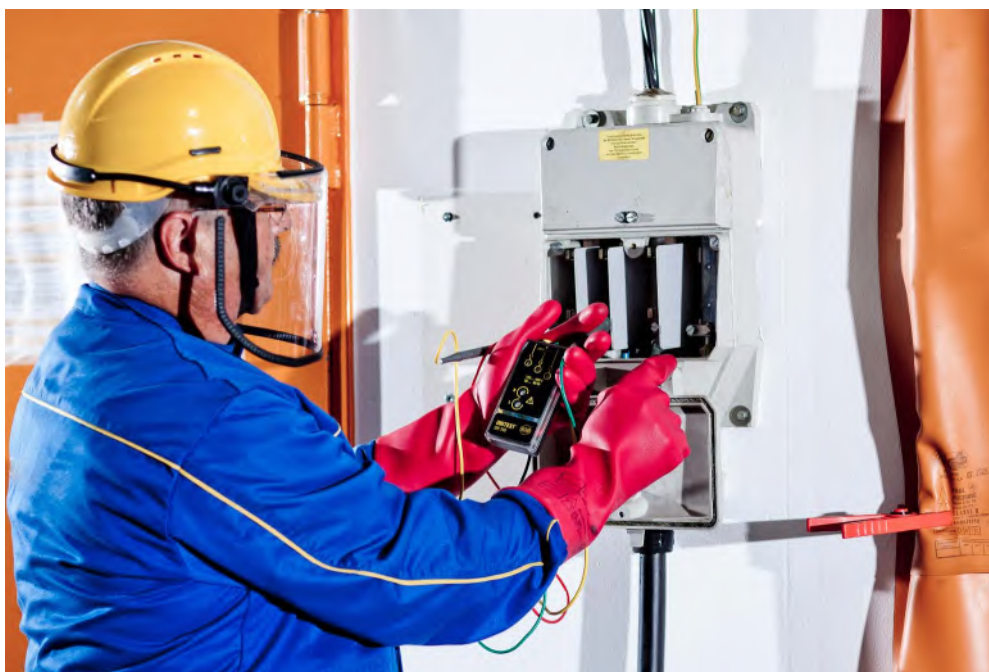
Abb. A 5-8 Arbeiten am Hausanschlusskasten
