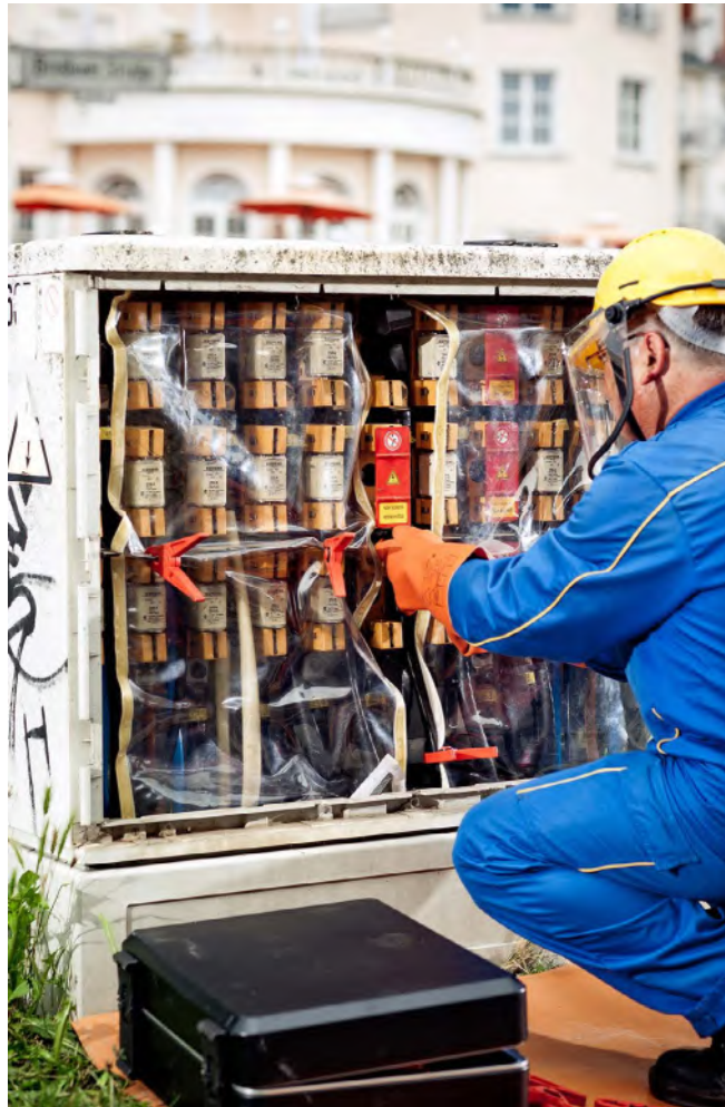
Abb. A 6-3 Arbeiten am Kabelverteilerschrank: k_T = 1,5
