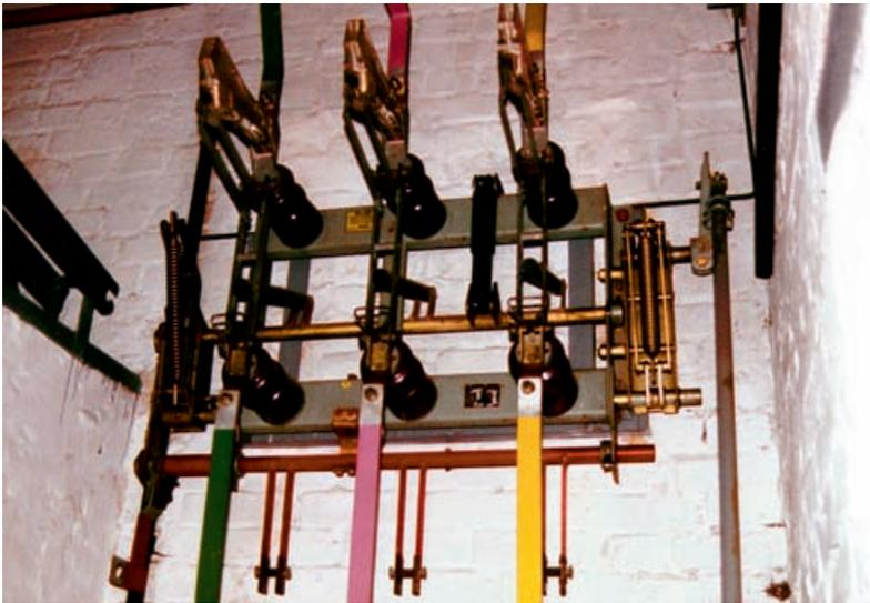
Bild 3.1.2 Lasttrennschalter
