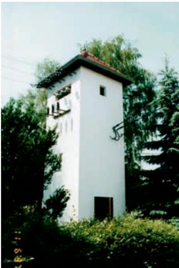
Bild 3.3.1 Freileitungsturmstation
