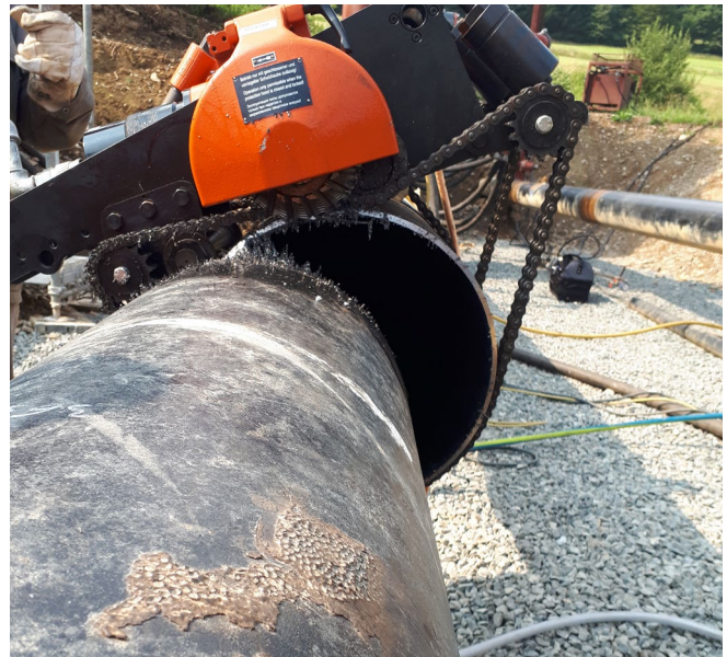
Abb. 43 Rohrfräse mit Druckluftantrieb
