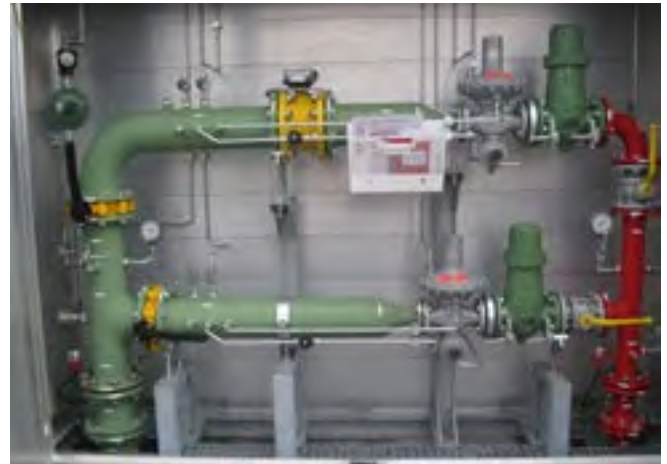
Abb. 15 GDRM-Schrankanlage
