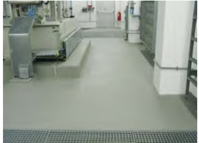
Abb. 39 Fußboden in einer Gas-Verdichterhalle (WHG-Aufbau, ableitfähig, rutschhemmend)
