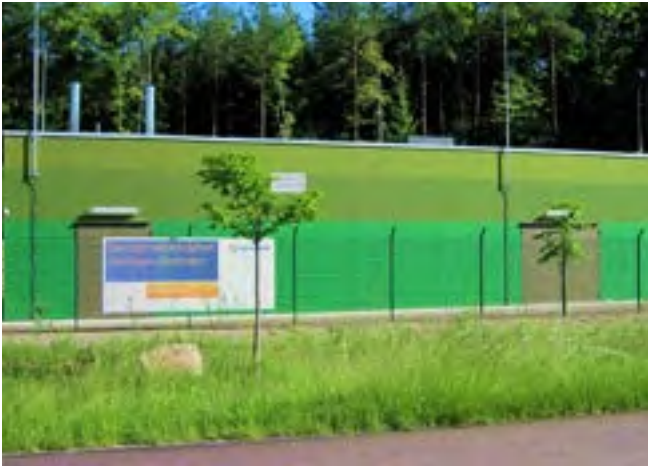
Abb. 14 GDRM-Anlage in einem Gebäude untergebracht
