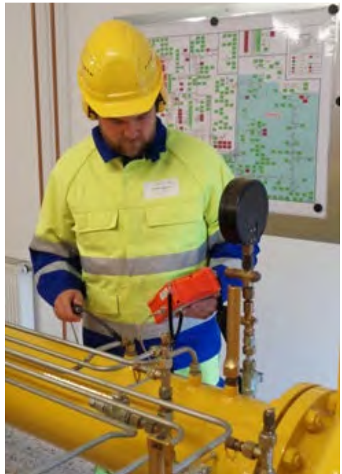
Abb. 28 Dichtheitskontrolle bei der Funktionsprüfung an einer GDRM-Anlage.
