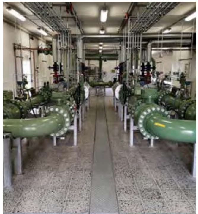
Abb. 40 Betonwerkstein-Platten in einer GDRM-Anlage
