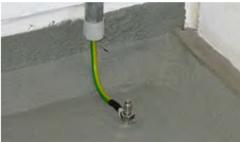
Abb. 37 Beispiel Erdungsanschluss für ableitfähigen Fußboden
