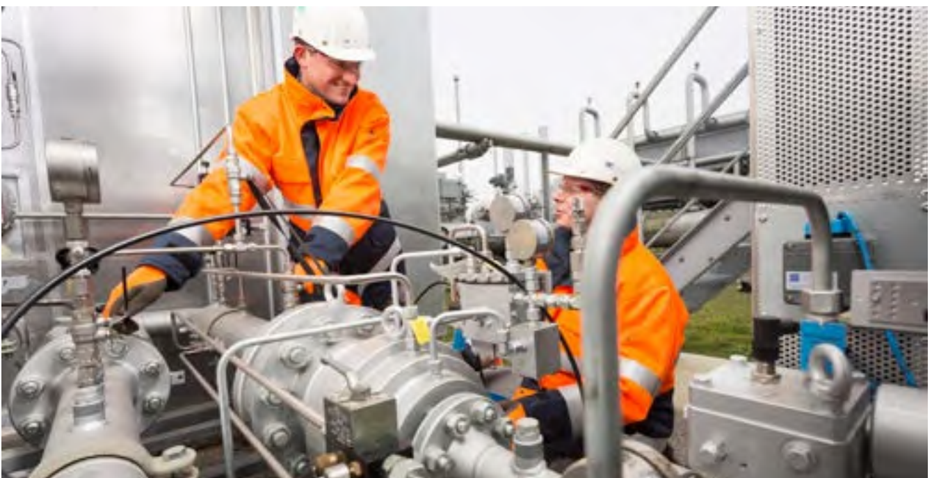
Abb. 8 Instandhaltungsarbeiten in einer GDRM-Anlage
