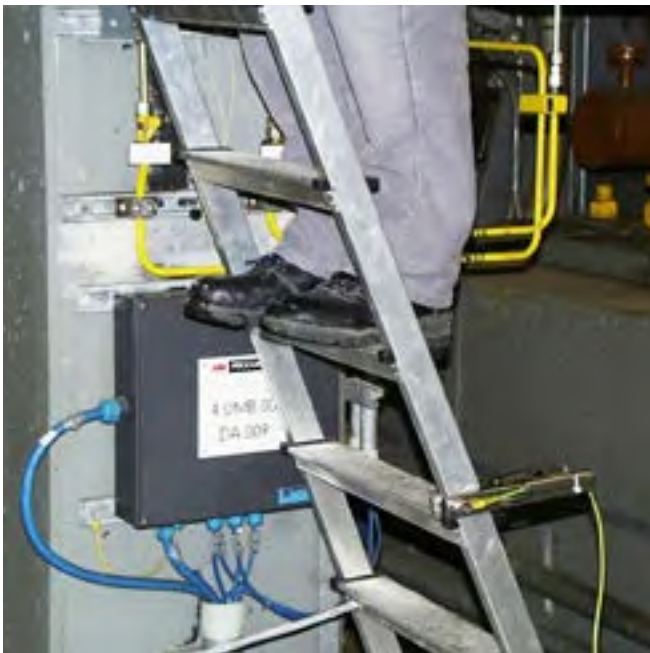
Abb. 42 Erdung einer mobilen Einrichtung (Stehleiter)
