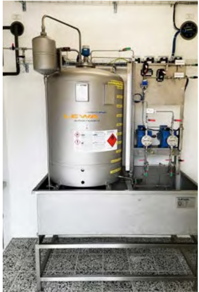
Abb. 13 Odorieranlage
