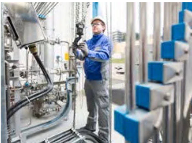
Abb. 27 Hebezeuge sind regelmäßig zu prüfen
