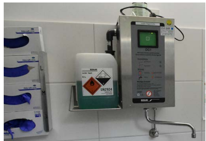
Abb. 10 Technische Lösung für die Entnahme eines des gebrauchsfertigen Desinfektionsmittels
