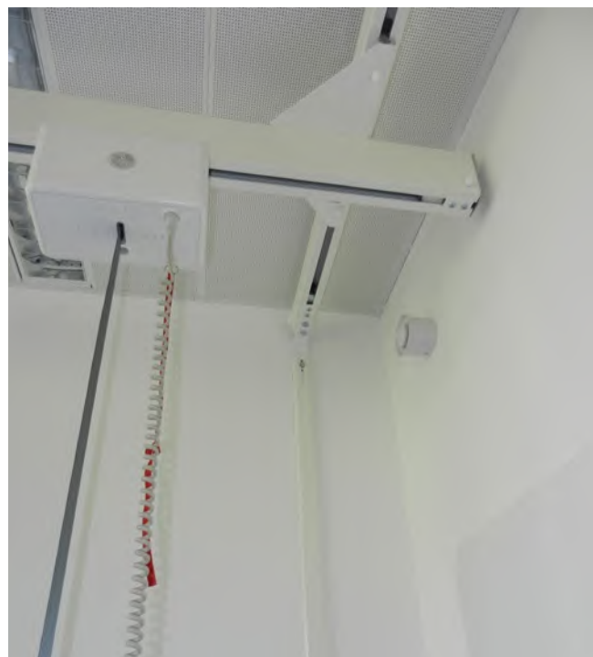
Bild 3: Portalmontage eines Patienten-Deckenlifters
