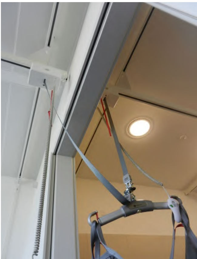
Bild 5: Deckenliftsystem mit Umhängemöglichkeit des Liftertuches am Türsturz
