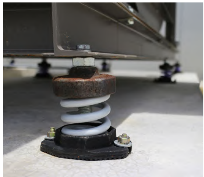
Abb. 9.6 Schwingungsisolierte Aufstellung einer Maschine
