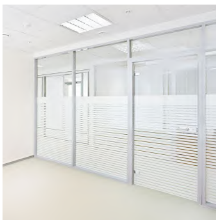
Abb. 6.3 Optische Kennzeichnung großer Glasflächen
