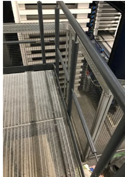
Abb. 4.8 Absturzsicherung an Verkehrswegen und Arbeitsplätzen
