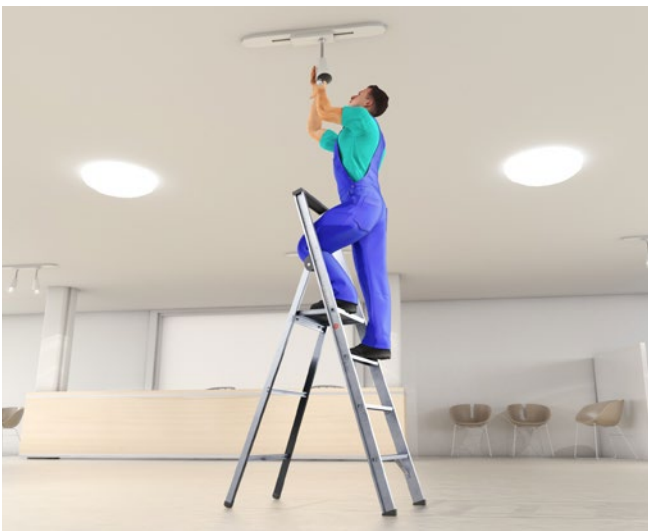
Abb. 57 Sicherer Stand auf der Stehleiter mit Plattform
