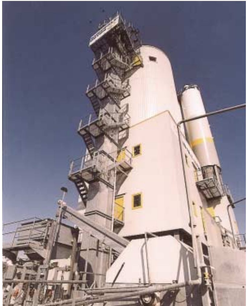
Abb. 37: Treppenaufgang um das Becherwerksgehäuse
