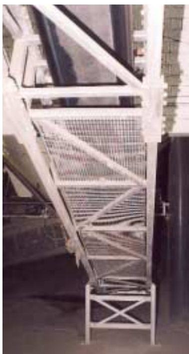
Abb. 21: Vollständige Verkleidung über einem Verkehrsweg
