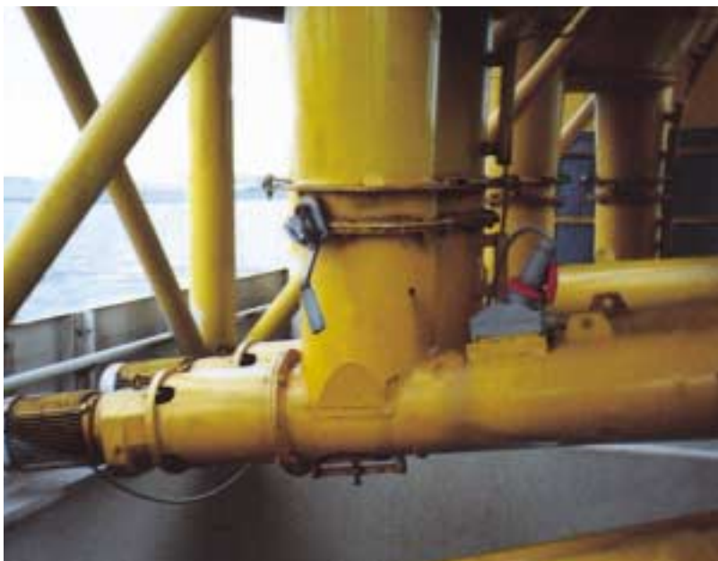
Abb. 41: Allpolige Trennung durch Steckvorrichtung
