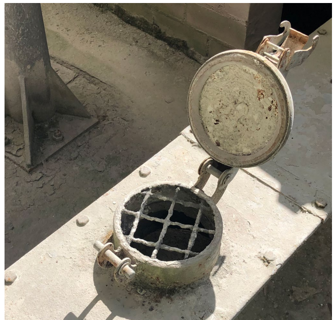
Abb. 35 Durch Gitter gesicherte Kontrollöffnung
