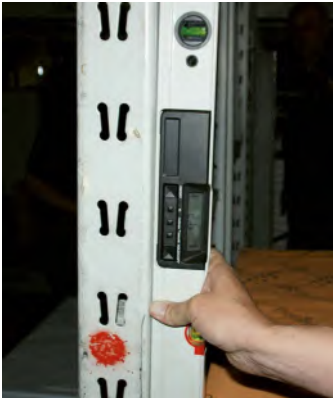
Abb. 10 Messung der Schiefstellung mit digitaler Wasserwaage
