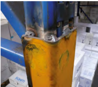
Abb. 11 Unfachmännisch geschweißte Stütze
