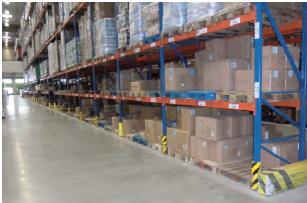
Abb. 19 Stützenschutz an allen Stützen
