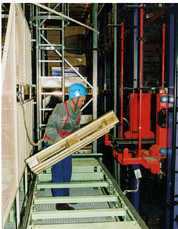
Abb. 22 Störungsbeseitigung an einer Stichbahn
