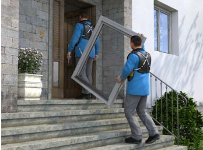
Abb. 6 Einsatz von Tragewesten beim Transport von Fenstern
