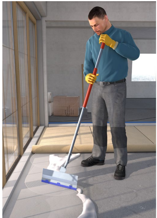
Abb. 20 Aufrechte Körperhaltung durch Einsatz eines Teleskopstiels
