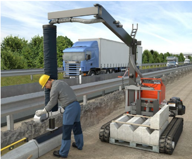
Abb. 14 Vakuum- und pneumatische Hebehilfen
